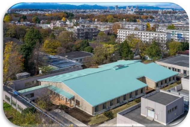
新 緩和ケア病棟 (奥に旧緩和ケア病棟)
